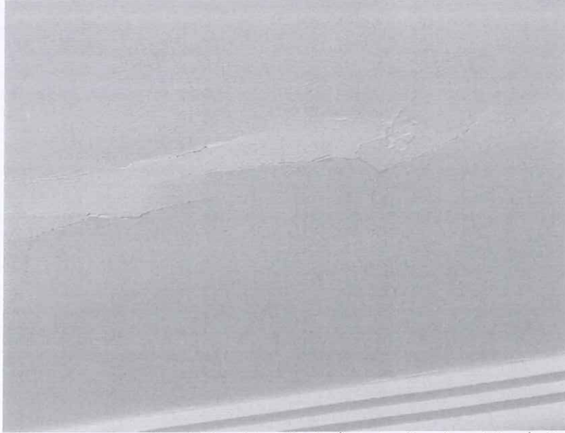
صورة رقم (١٧) : شروخ عشوائية بالسقف ونظر بالغطاء الخرساني ببعض الوحدات
