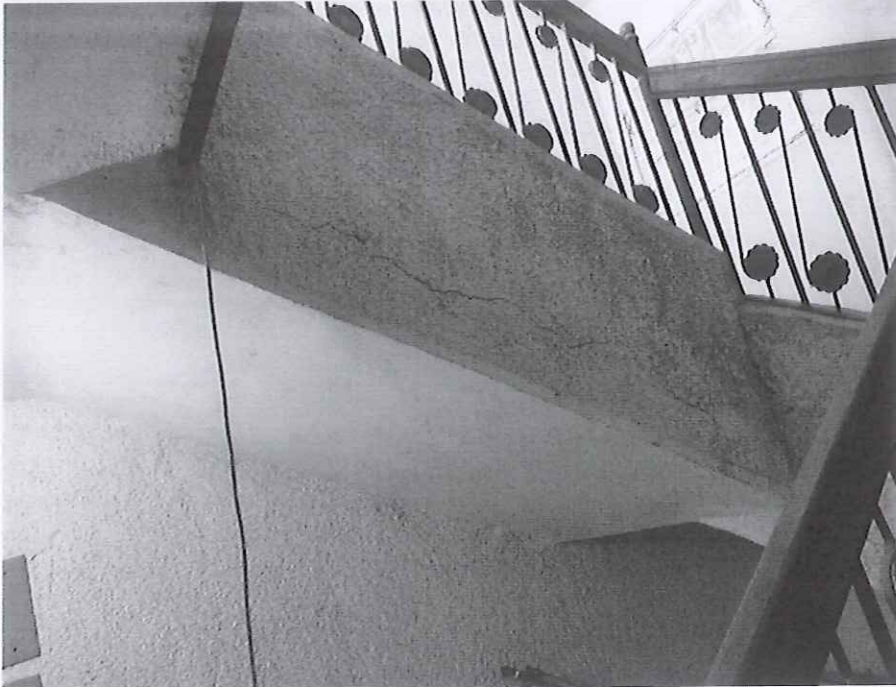
صورة رقم (١١) : شروخ فاصلة بين البلاطات الخرسانية للسلم ومباني الكوبسنة
