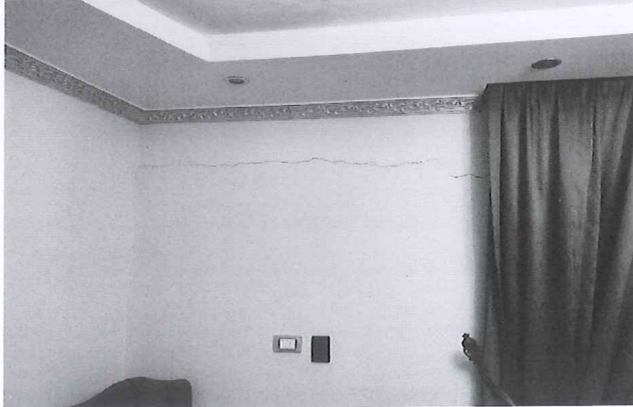
صورة رقم (١٢) : شروخ أفقية بحوائط المباني ببعض الوحدات
