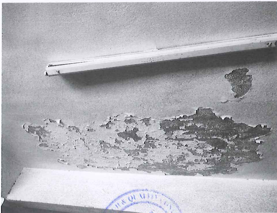
صورة رقم (٤) : نشع وتمليح بسقف البديوم
