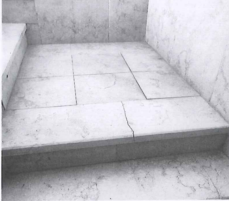
صورة رقم (٩) : كسور وشروخ وتطيل في رخام درج السلالم
