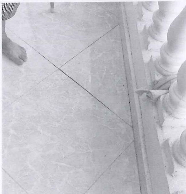
صورة رقم (١٥) : انتفاخ فى بلاطات سيراميك الأرضيات ببعض الوحدات
