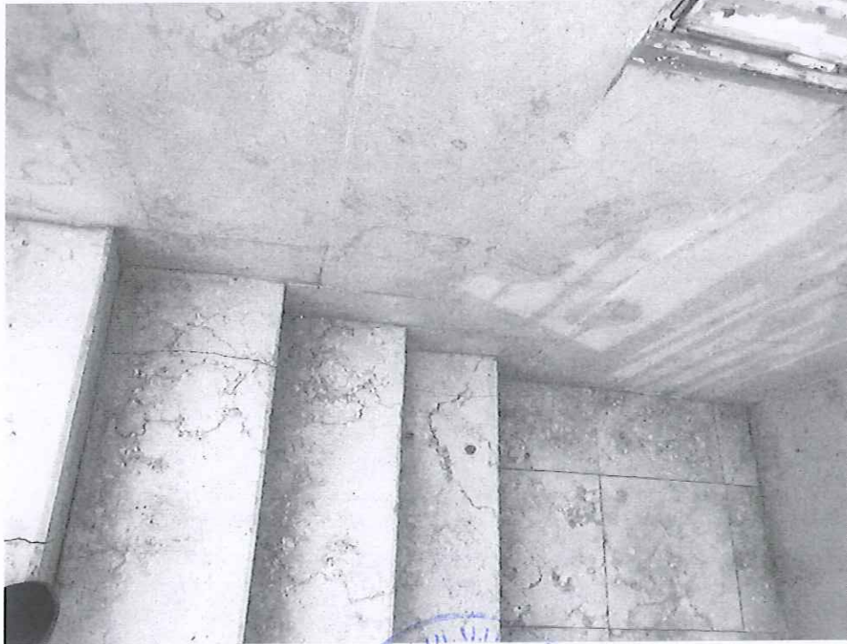
صورة رقم (١٠) : كسور وشروخ في رخام درج السلالم
